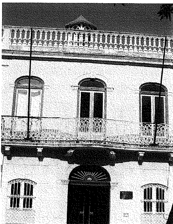
Figura LXVIII. Fachada da Casa Mora – Sede do Museu Municipal de Montijo
