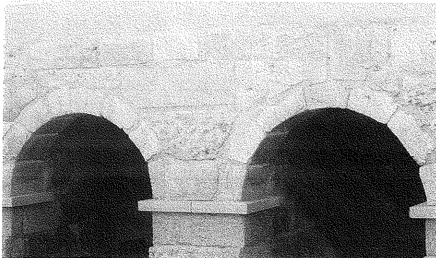
Figura LXVII. Pormenor dos infernos do moinho, onde se nota a parte original da parte recente (reconstrução)
