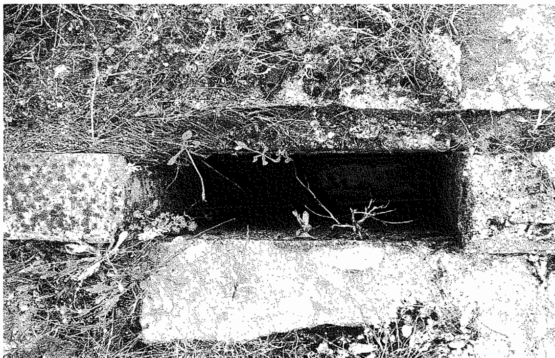
Figura LIV. Buraco onde encaixava a comporta de um dos poços
