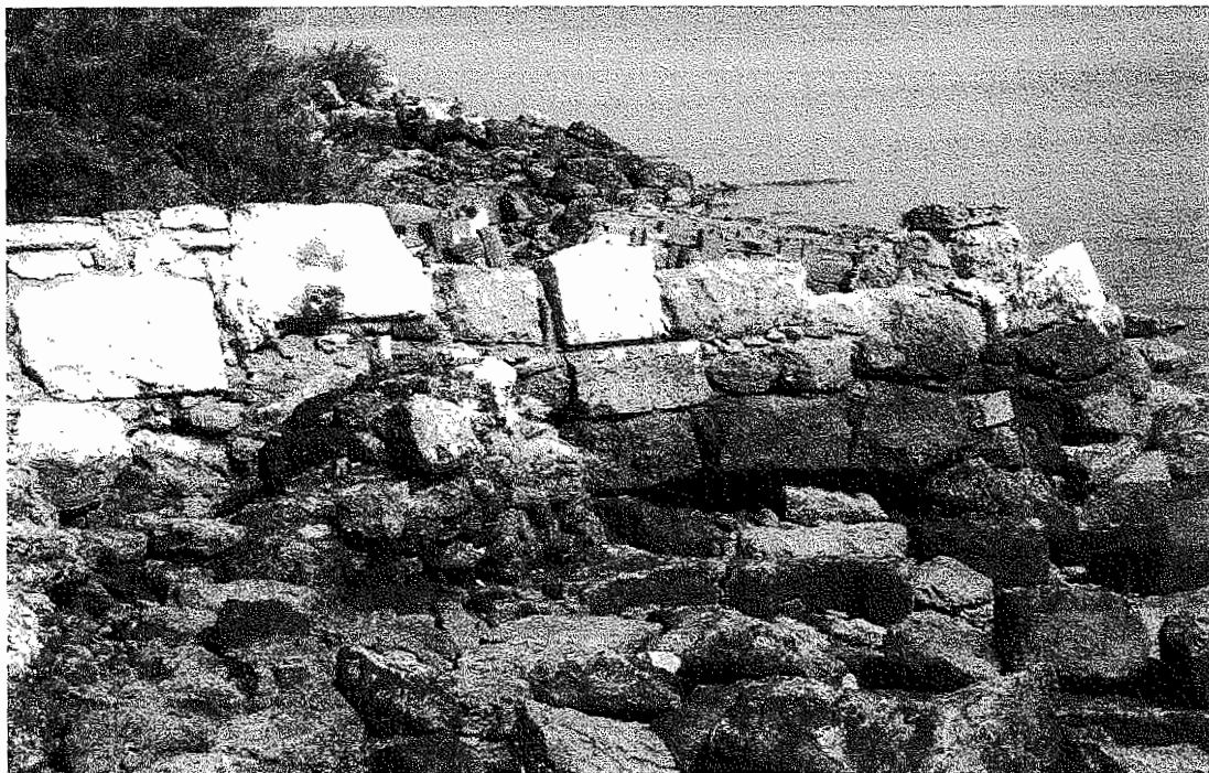
Figura XLIV. Parte da estrutura do Moinho do Cabo (21 de Abril 2007)
