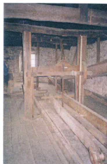
Diversas estruturas do engenho hidráulico
