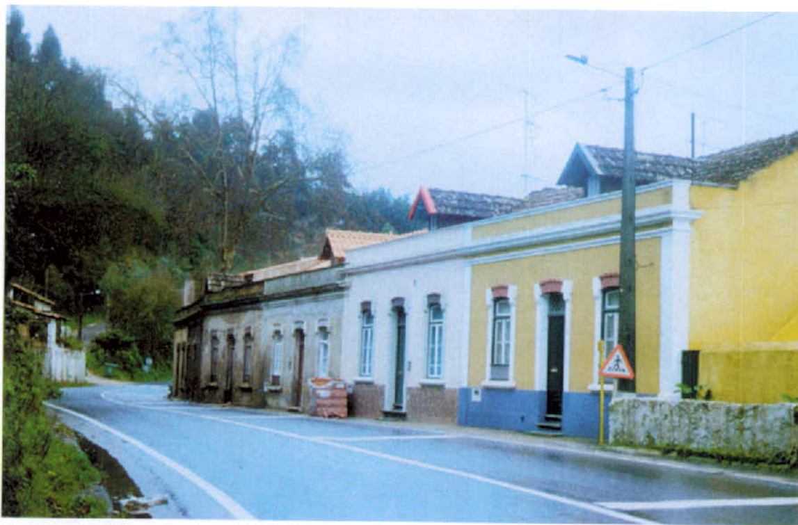
Estado actual das casas junto à Fábrica
