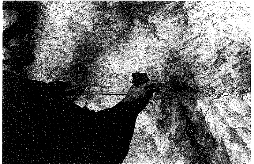
Fotografia 8 – Colocação dos canelos e da cunha.
