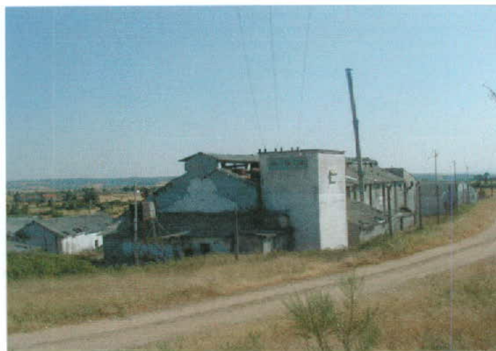
Fig. 6.16. Em primeiro plano, a 'cabine de alta tensão que abastecia o forno de fundição situado na oficina de tratamento de mistos, o edifício principal da imagem. Mais ao fundo, à direita o edifício do antigo laboratório, onde será instalada a mediateca.
