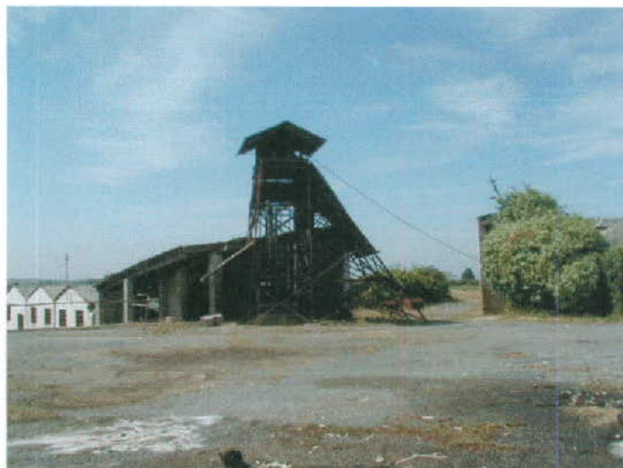
Fig. 5.2. O cavalete e ao fundo, à esquerda, os edifícios das antigas oficinas gerais.
