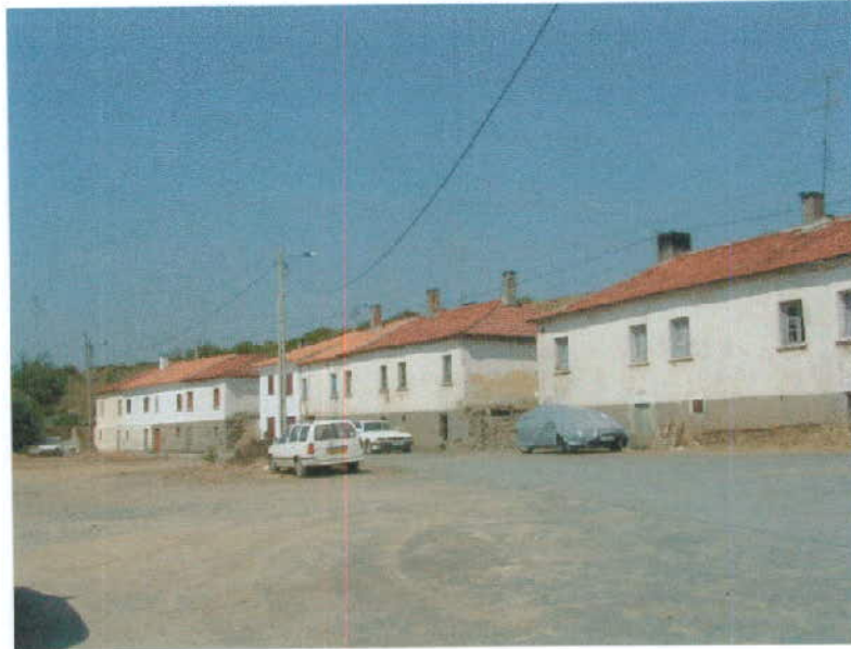
Fig. 6.20. Os três blocos de construções mais perto da mina, na zona operária, actualmente apenas em parte habitados.
