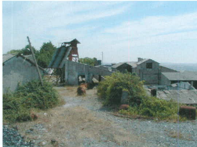
Fig. 5.1. Vista geral abrangendo o cavalete e, à direita, os edifícios da lavaria. Em primeiro plano vêem-se restos da linha férrea e restos das vagonetas.
