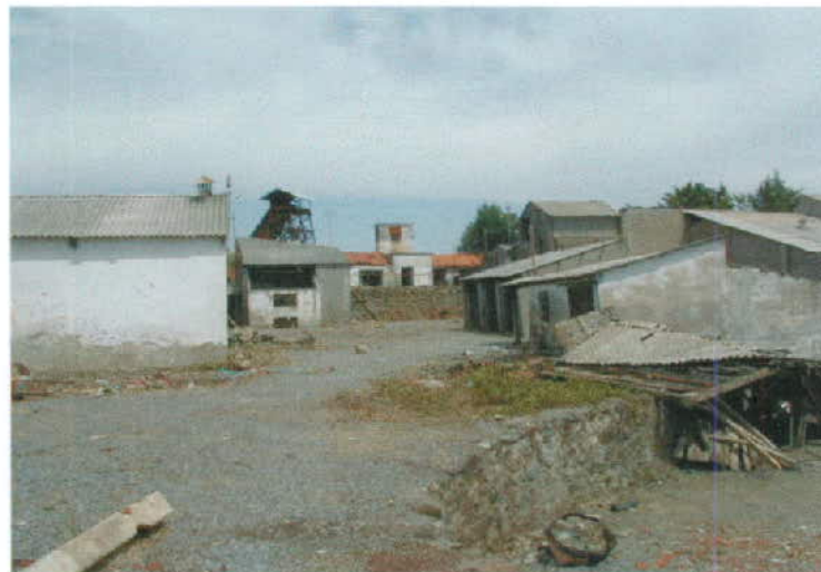
Fig. 6.2. Vista geral do complexo, tirada do lado sul. À esquerda os edifícios das antigas oficinas gerais, ao centro as construções que abrigavam a britagem e à direita, em primeiro plano as casas das bombas de água (actualmente inexistentes) e, mais atrás, a lavaria.
