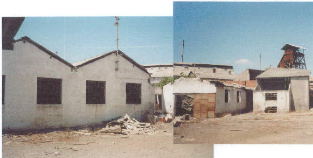
Fig. 6.4. Edifícios das antigas oficinas gerais (à esquerda), fundição e armazém geral (ao centro).
