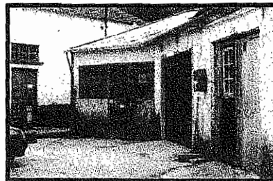
Fig. 26 - Entrada da Galeria 6 na Panasqueira.
