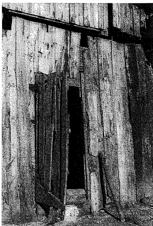
23 – Pormenor de porta de acesso (usada em tempo de chuva).
