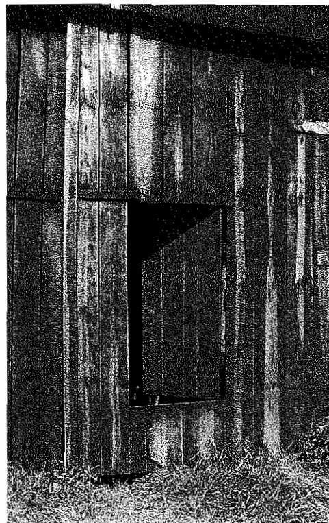
13 – Pormenor de porta de acesso (usada em tempo de chuva).
